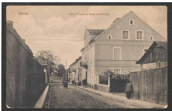
Budynek dawnego urzędu skarbowego, zwany potocznie Kasą Powiatową, przy ówczesnej ulicy Browarnej (później Piwnej), a obecnie ulicy Z. Urbanowskiej. Fot. M. Pęcherski, druga dekada XX w.
